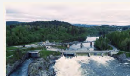
Davikfoss vannkraftverk i Modum kommune i Buskerud. Foto: Å Energi.
